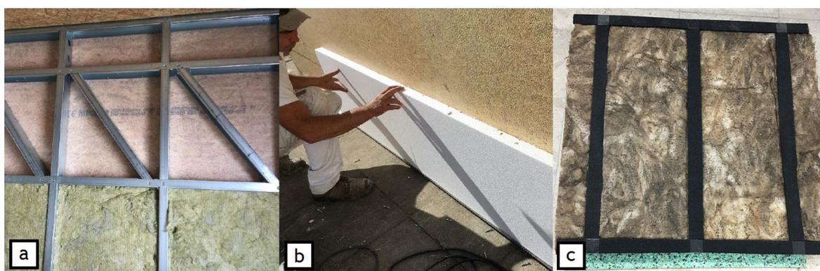
Figura 2.7 – Materiais de isolamento térmico: a) lâ de rocha – interior das paredes; b) poliestireno expandido – exterior das paredes; c) borracha reciclada – tiras de corte térmico (Pereira e Santos, 2019).
