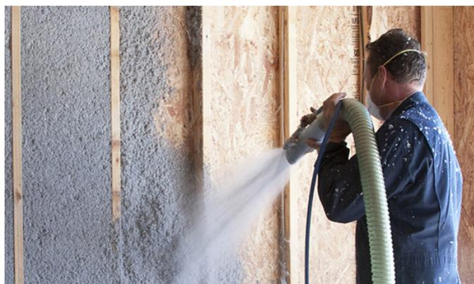
Figura 4.11 – Aplicação de fibras de celulose por projeção (DDN, 2020).
