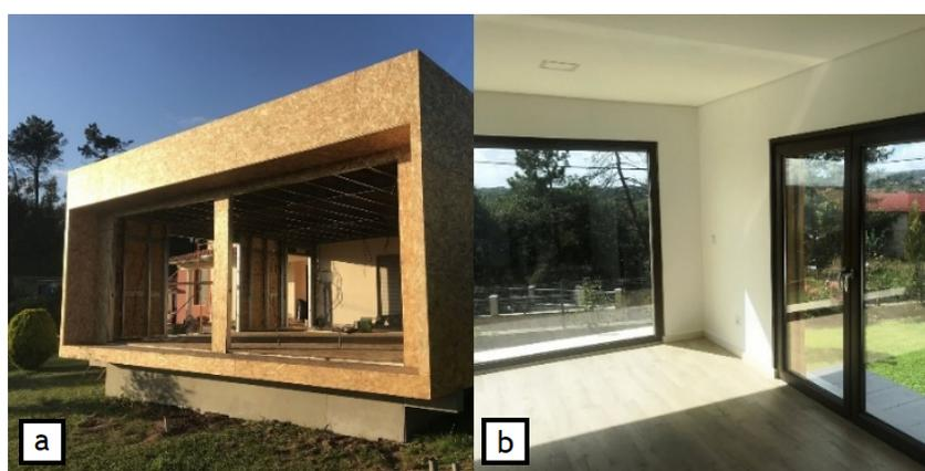
Figura 2.4 – Painéis de revestimento: a) placas OSB; b) placas de gesso cartonado (Futureng, 2020b).
