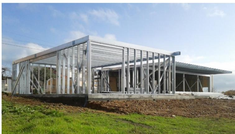
Figura 2.1 – Estrutura de uma moradia construída em LSF (Perfisa, 2020).
