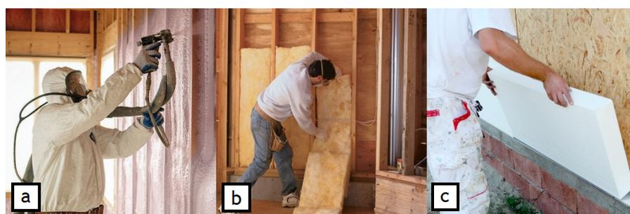
Figura 4.1 – Classificação dos materiais de isolamento térmico de acordo com a forma: a) espumas projetáveis; b) mantas; c) placas rígidas (Reichel Insulation, 2020; Green Building Advisor, 2020a; Forte EPS Solutions, 2020).
