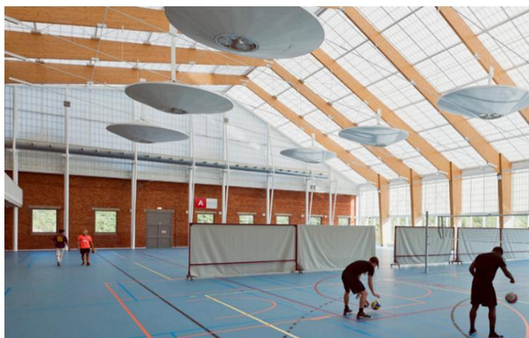
Figura 4.19 – Aplicação de aerogel em fachadas e coberturas para aproveitamento de luz natural (Kalwall, 2020).
